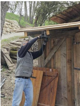
Autre étape délicate : les volets. Il faut poser le guide, ajuster la taille et poser les charnières pour les fixer à l'intérieur.
