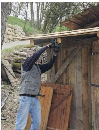
Autre étape délicate : les volets. Il faut poser le guide, ajuster la taille et poser les charnières pour les fixer à l'intérieur.
